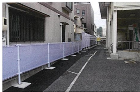
サポートセンターフェンス工事完成 3月 令和3年12月から工事が開始された地震 対策の為の工事でブロック塀が撤去され、 白いフェンスが設置されました。
